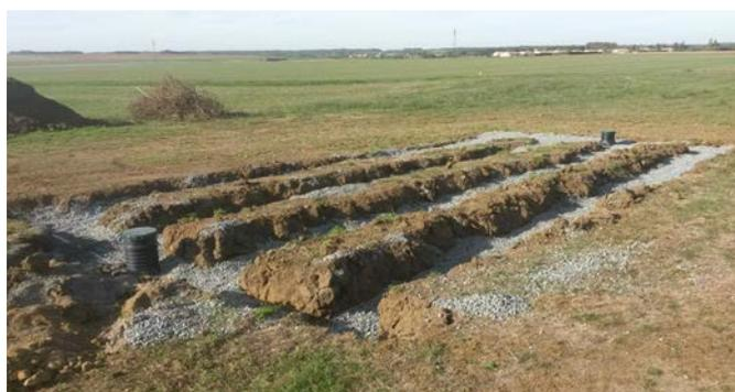
↳ Exemple d'installation photographiée lors d'un contrôle avant remblaiement
